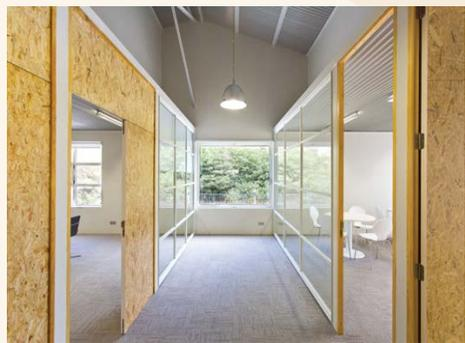
LP OSB Home es un tablero que se ha diseñado para diversas aplicaciones que requieren baja exigencia de carga, pero que aprovechan su rigidez, uniformidad y modulación por sobre otro tipo de materiales.
